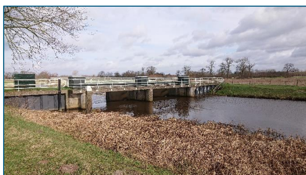
Stuw in het noordelijke deel van het deelgebied.
